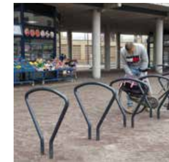
DE CLIP KLEUR RAL 7016 MET FUNDERING ONDER MARVELD AFM 70°/75CM | AFSTAND 90CM LEVERANCIER: STREETLIFE
