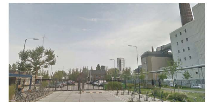
Zicht vanaf de energiecentrale
